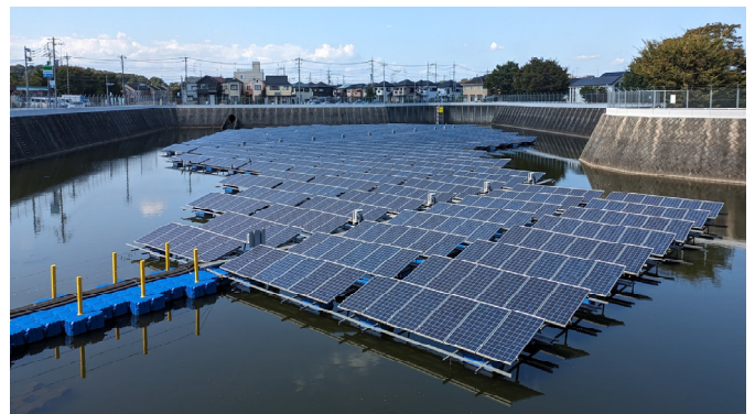
図2 所沢市松が丘調整池（ためき池）のフロートソーラー
